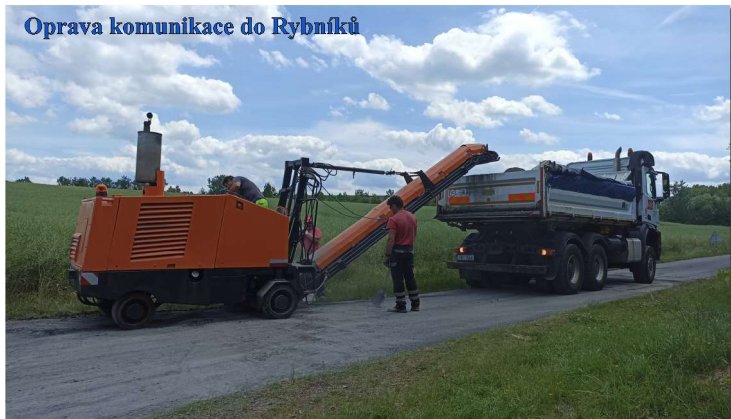
Oprava autobusového zálivu
