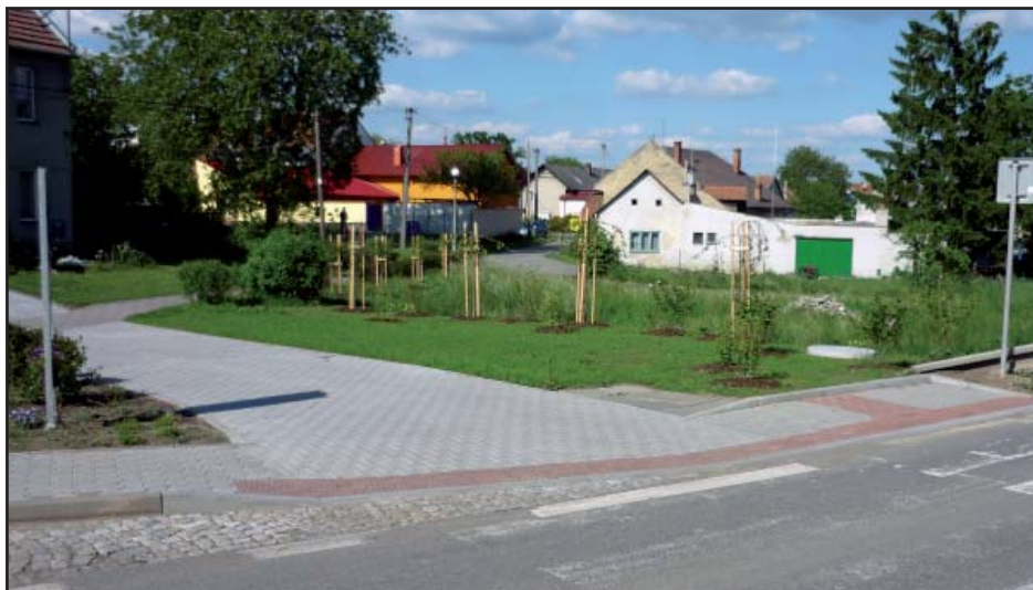
Napojení přechodu pro chodce v Dlouhé Vsi květen 2014
